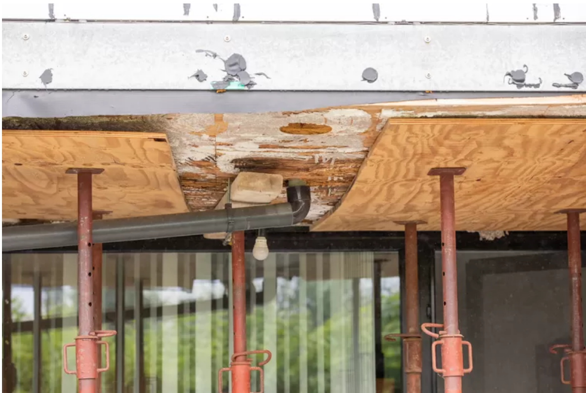
De houtstructuur van het gebouw is rot. Beeld Mine Dalemans
